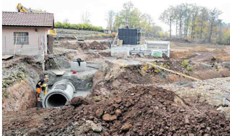
Die Dimensionen des Regenrückhaltebeckens und des Retentionsbeckens sind schon gut erkennbar.
